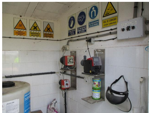
Il·lustració 18. Sobrelevació Ter: emmagatzematge i dosificació d'hipoclorit sòdic
