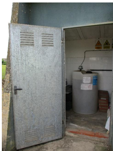
Il·lustració 18. Sobrelevació Ter: emmagatzematge i dosificació d'hipoclorit sòdic
