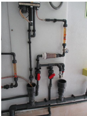
Il·lustració 22. ETAP La Verneda: sala de dosificació de reactiu i d'analitzadors en línia
